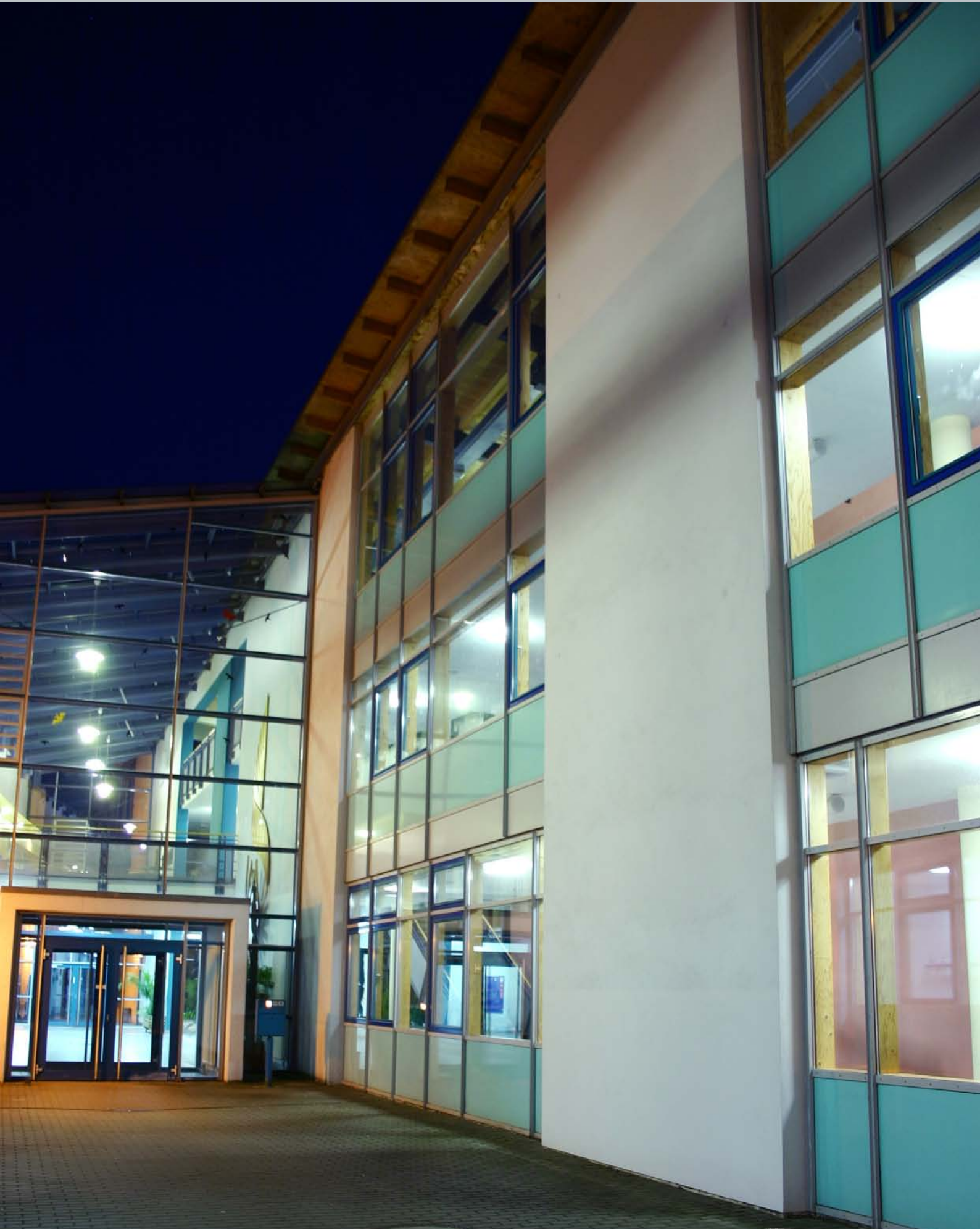
beleuchtete Glasfront des Innenhofes
